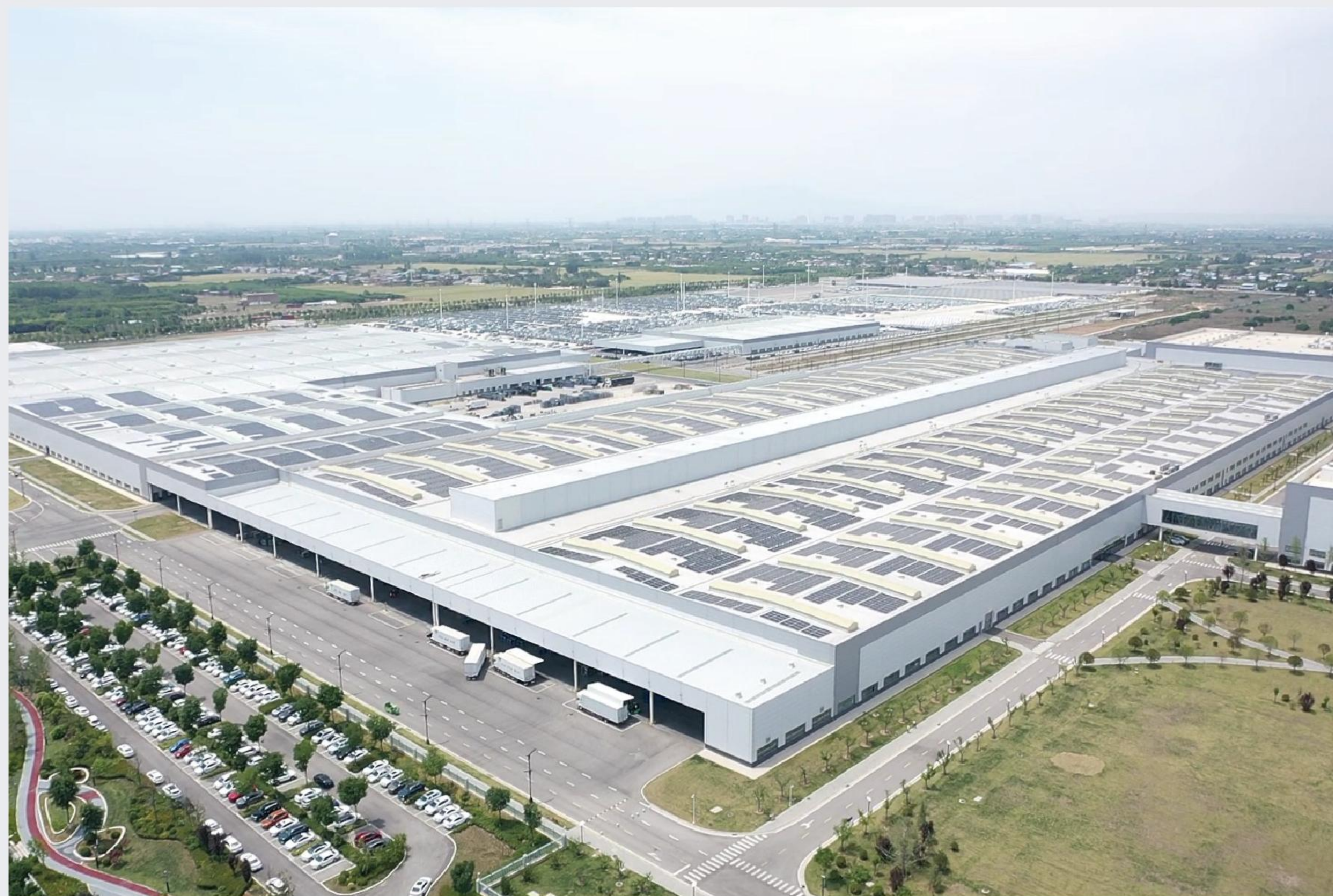
smart精灵#1制造工厂太阳能发电系统
