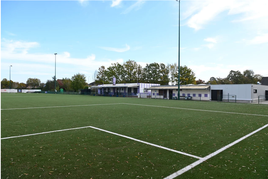
▲ De nieuwe kleedkamers (rechts) sluiten aan op het bestaande gebouw.
