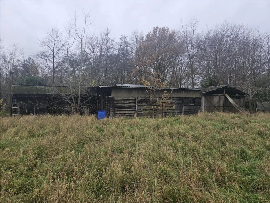
▲ Een van de koterijen die gesloopt worden.
